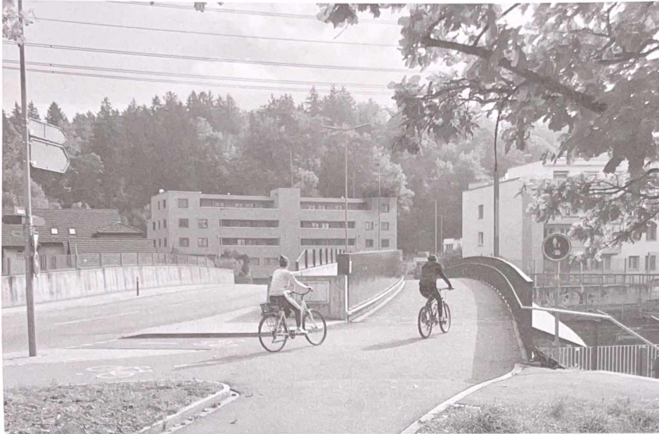
Bsp. 1: Velobrücke Brandrietstr./Bahnhofstr.): Wegen der hohen Abschränkung sieht ein auf der Brücke in Richtung Zentrum fahrender Velofahrer entgegenkommenden Veloverkehr erst in letzter Sekunde.
