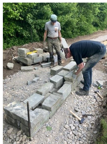
Trockenmauerbau Tschuttiwiese
